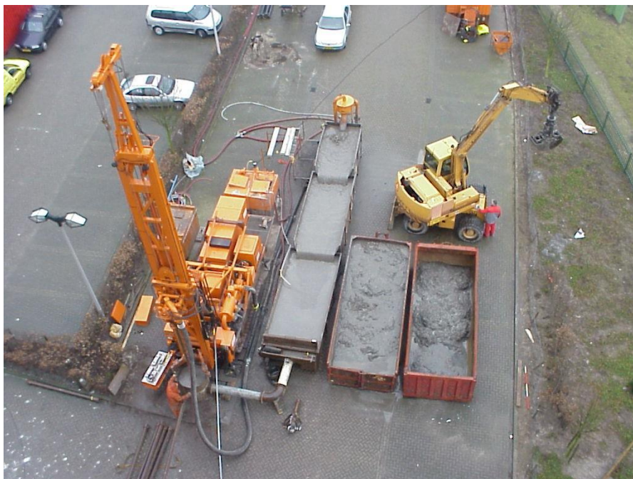
Figuur II-1: Boorstelling zuigboren
